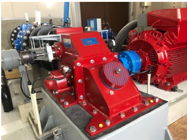
▲発電機 (写真奥が入水口)
