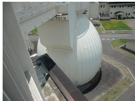
▲30日間 35℃に加温され、汚泥の有機物を減らし、量を少なくする消化タンク
