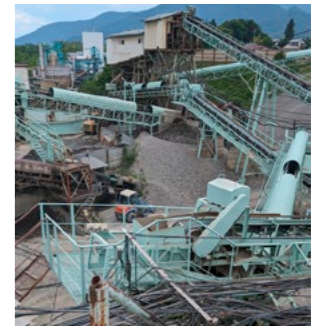
▲砕石を作業用途別に分けるため、場内に張り巡らされている多数のベルトコンベア
