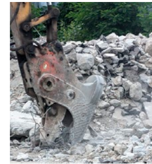
▲コンクリートを砕き有筋を取り除く破砕機
